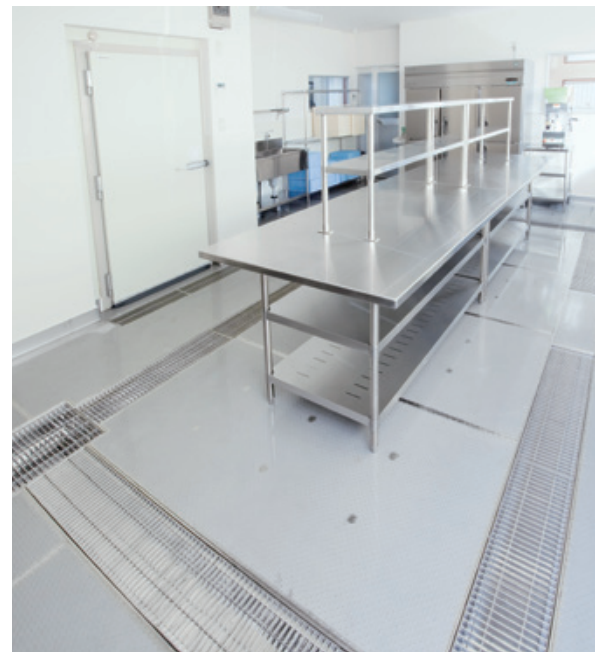
ポルカプレート®・側溝施工例
