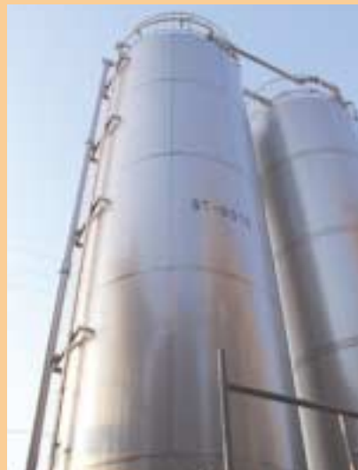
200トン液糖貯槽タンク
