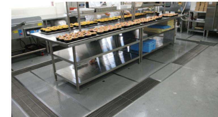
昂水産のセントラルキッチンは、タニコーステンレスフロアシステム
