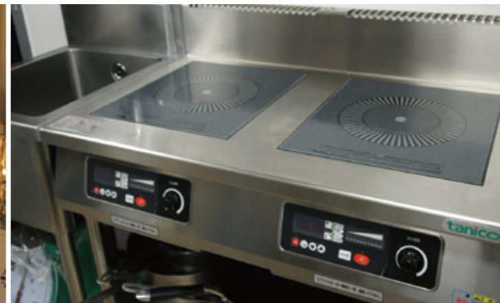
オール電化の涼しい厨房環境が大好評
