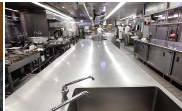
快適に仕事をこなせる「涼厨」仕様の厨房、ステンレス一枚板の天板
